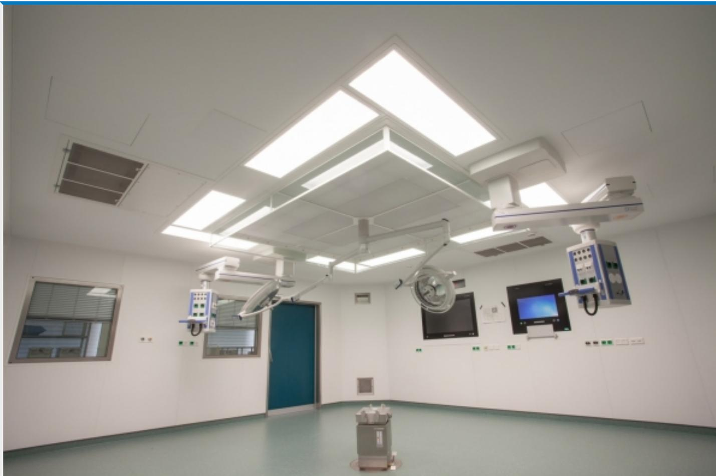
Flux laminaire ISO5 à recycleurs plafonniers intégrés : un système autonome pour vos salles à risque 4
